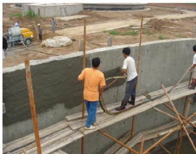
防水砂浆喷涂
