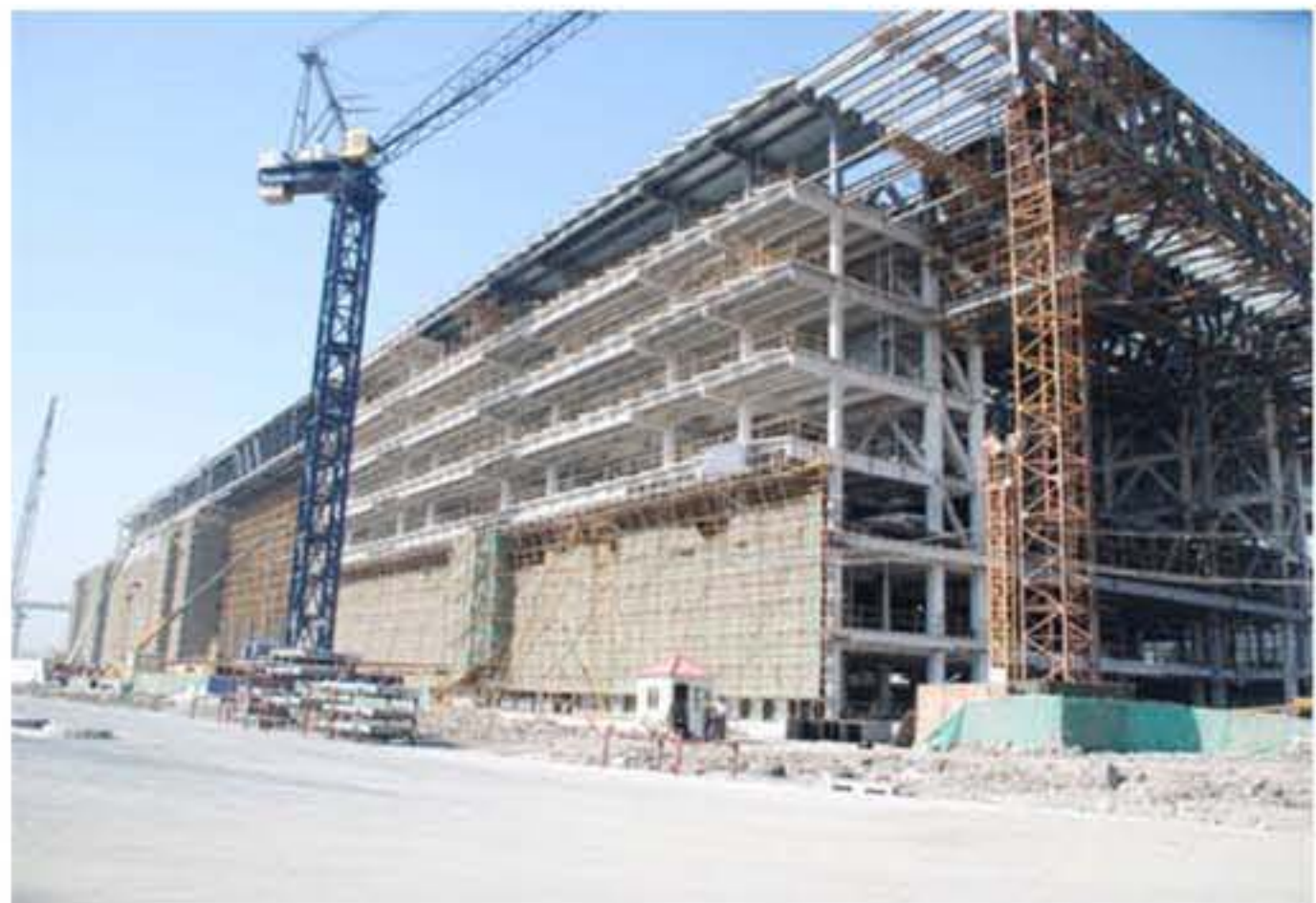
世博中心施工现场
