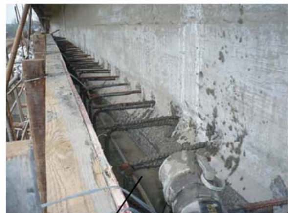
S5EF 电机功率：7.5kW，排量 90l/min 二台搅拌机排量，抵不过 S5EF 的排量
