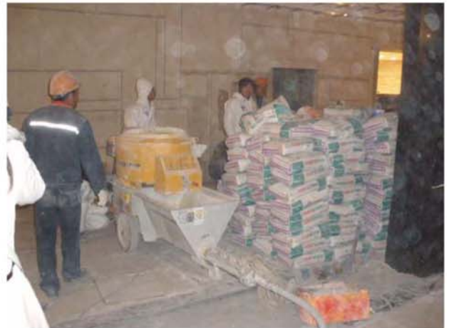
设备进场 S5EV/TM
