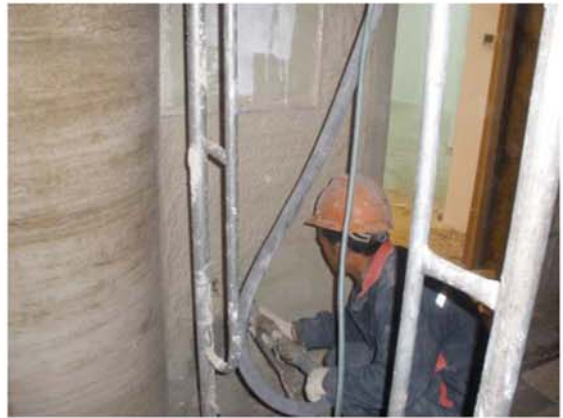
正在进行机械化喷涂
