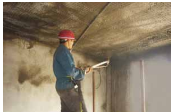
顶喷混凝土修复
