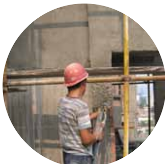
外墙抹灰砂浆喷涂
