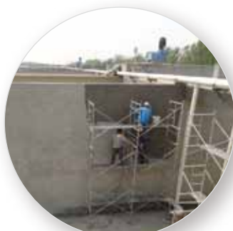
防火砂浆喷涂
