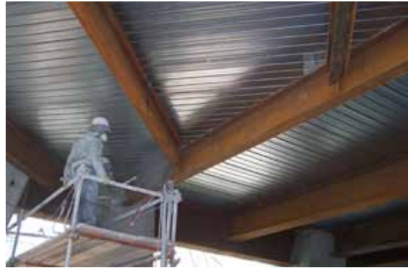
防火砂浆喷涂
