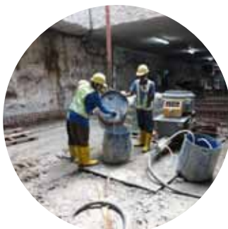
隧道内砂浆喷涂
